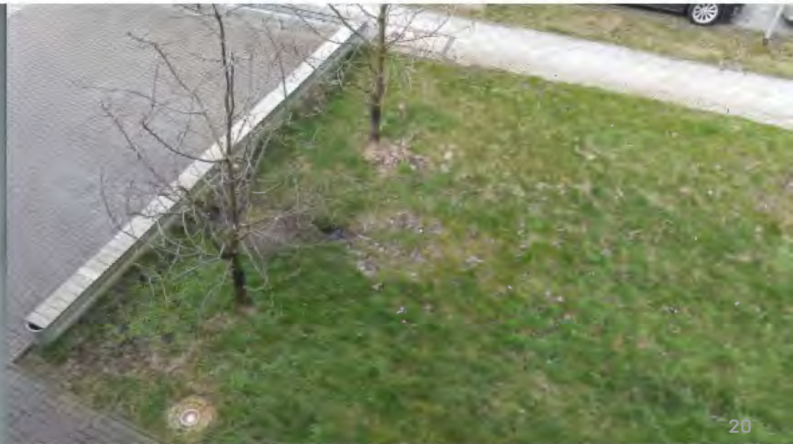
Rigolen: Vollständige Versickerung des Regenwassers
