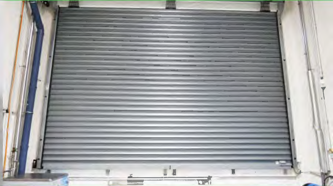
Innenliegende Stahlrollladen im Erdgeschoß
