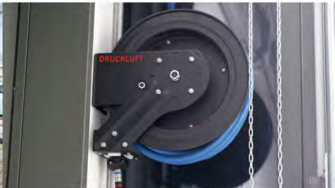
Druckluft (Entnahmestellen im gesamten Erdgeschoß)
