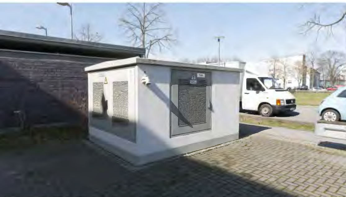
Transformator 630 kVA
