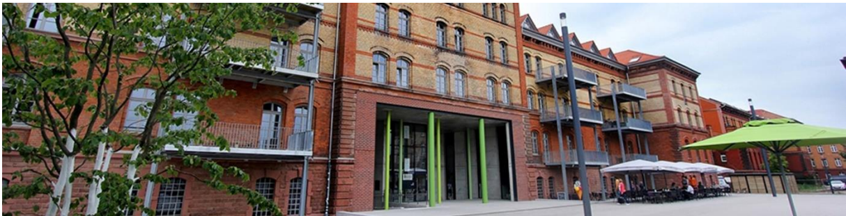
Links vom Durchgang, unterhalb der Balkone
