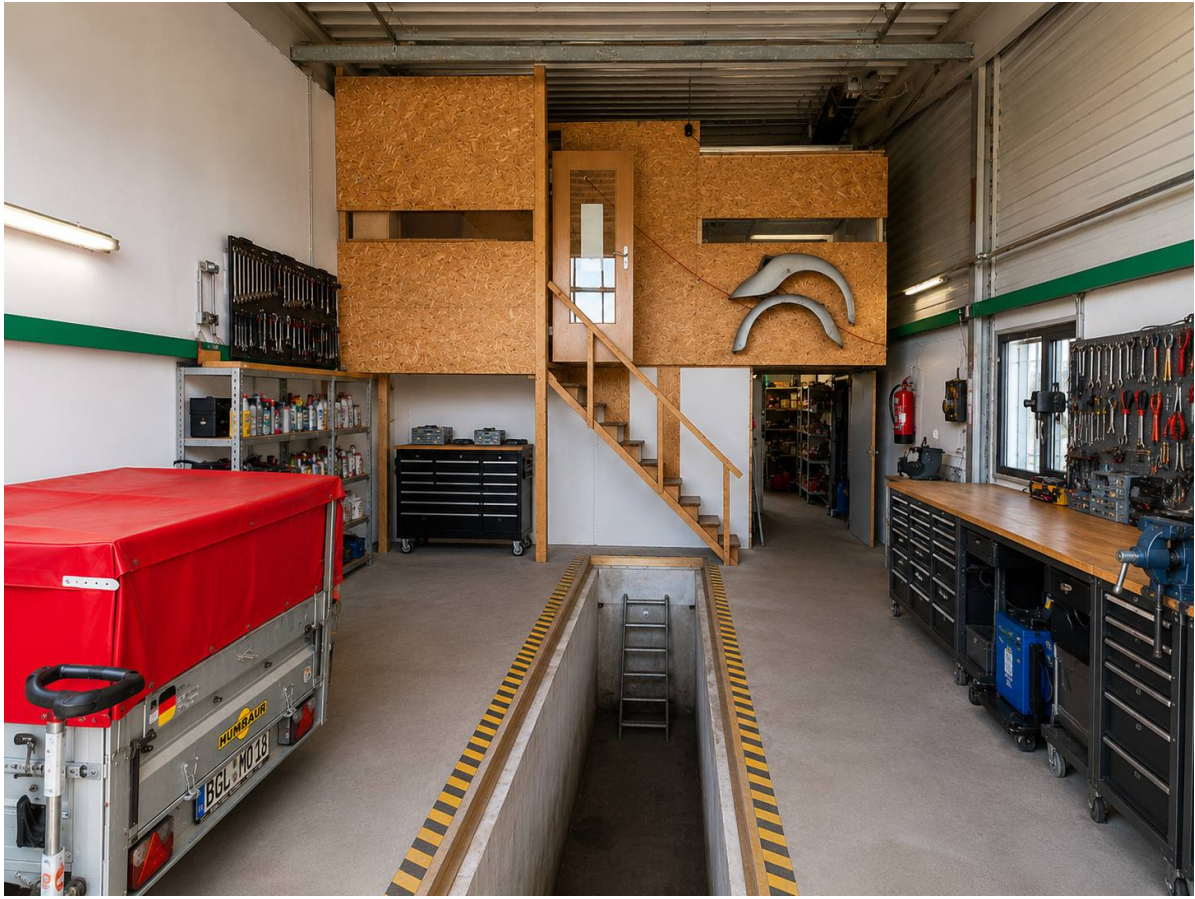
Zweiter Werkstattbereich mit durchgehender Montagegrube, Werkbankflächen und Zugang zu den Nebenbereichen.
