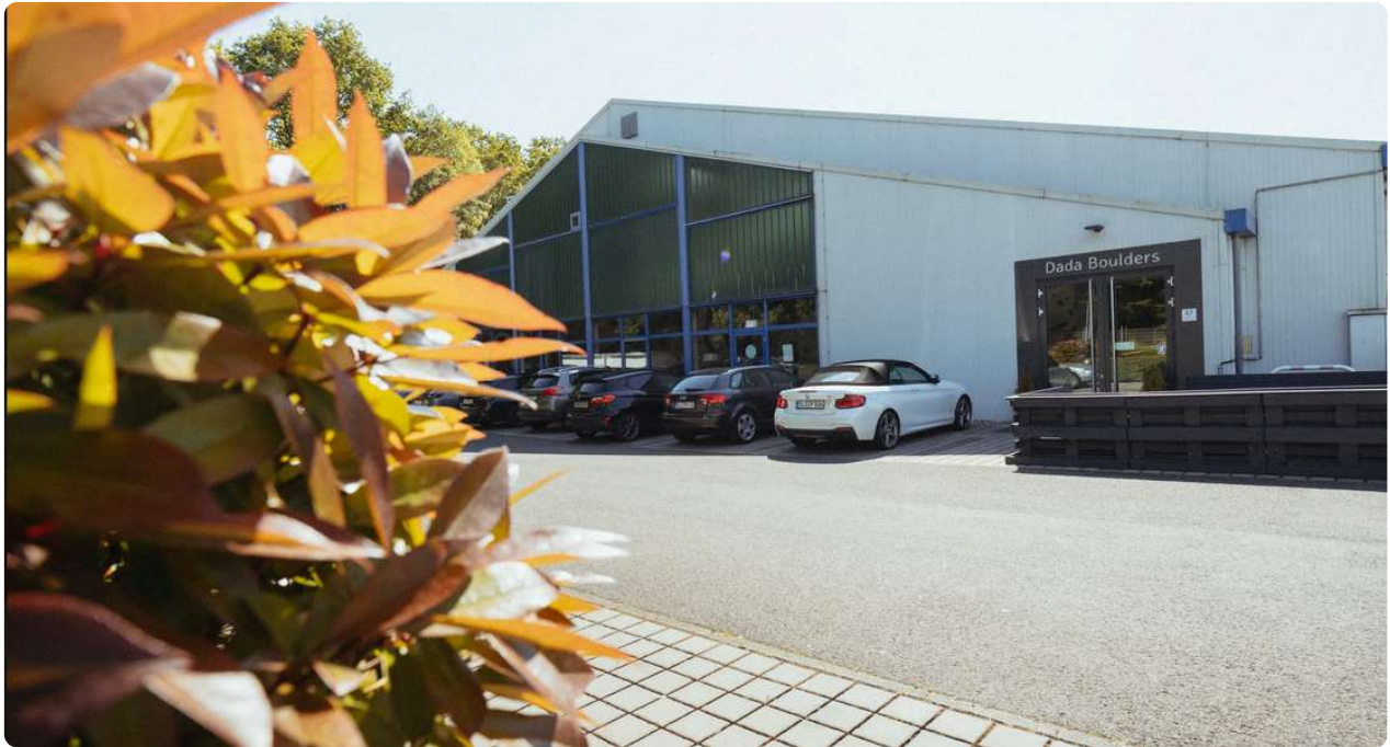
Außenansicht · Eingangsbereich, Provinzialstraße 57
