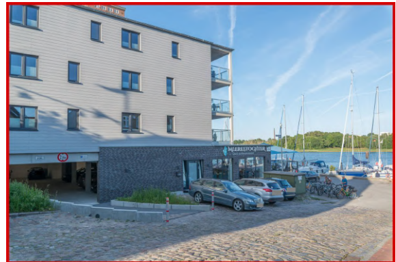
Einfahrt in die Tiefgarage
