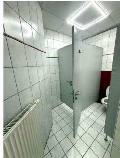
Toilettenkabine mit Kacheln
