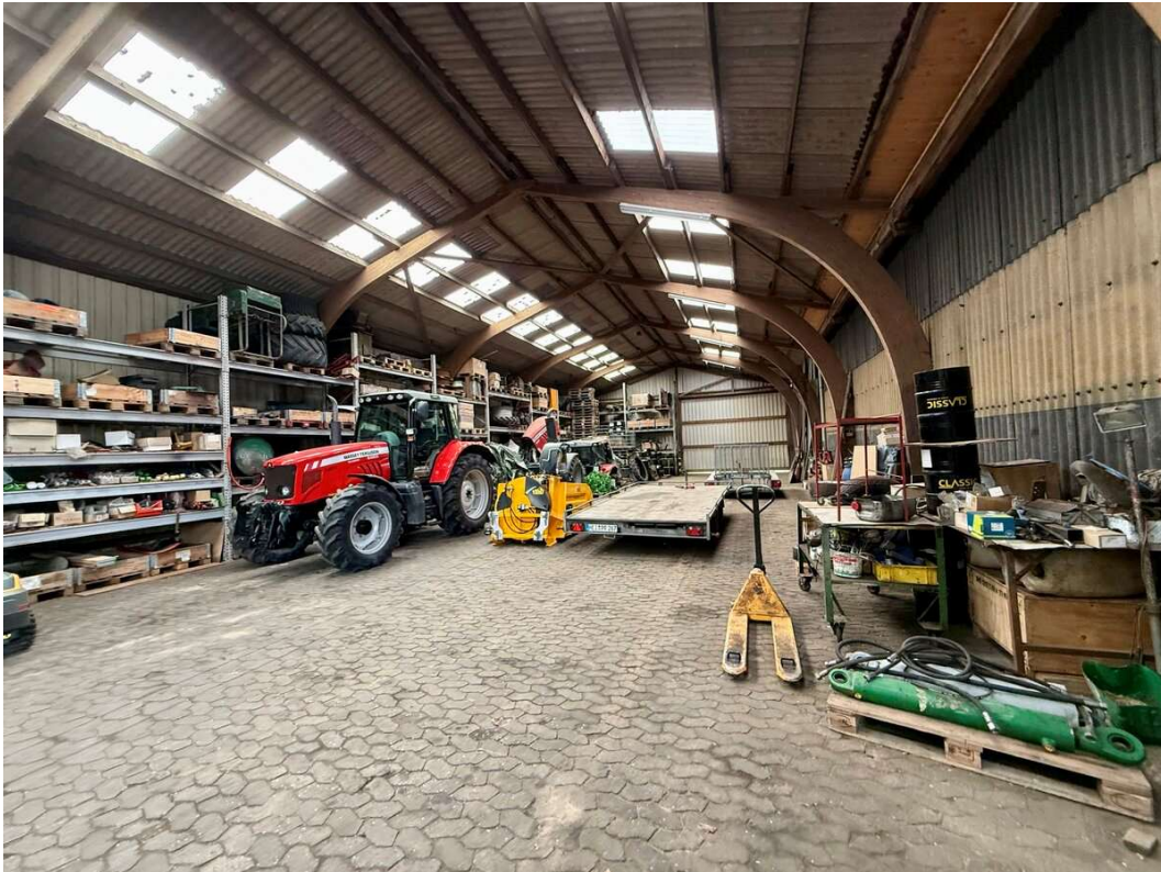
Bogenhalle mit Brettschichtholz-Tragwerk – wesentlicher Bestandteil der Lagerinfrastruktur
