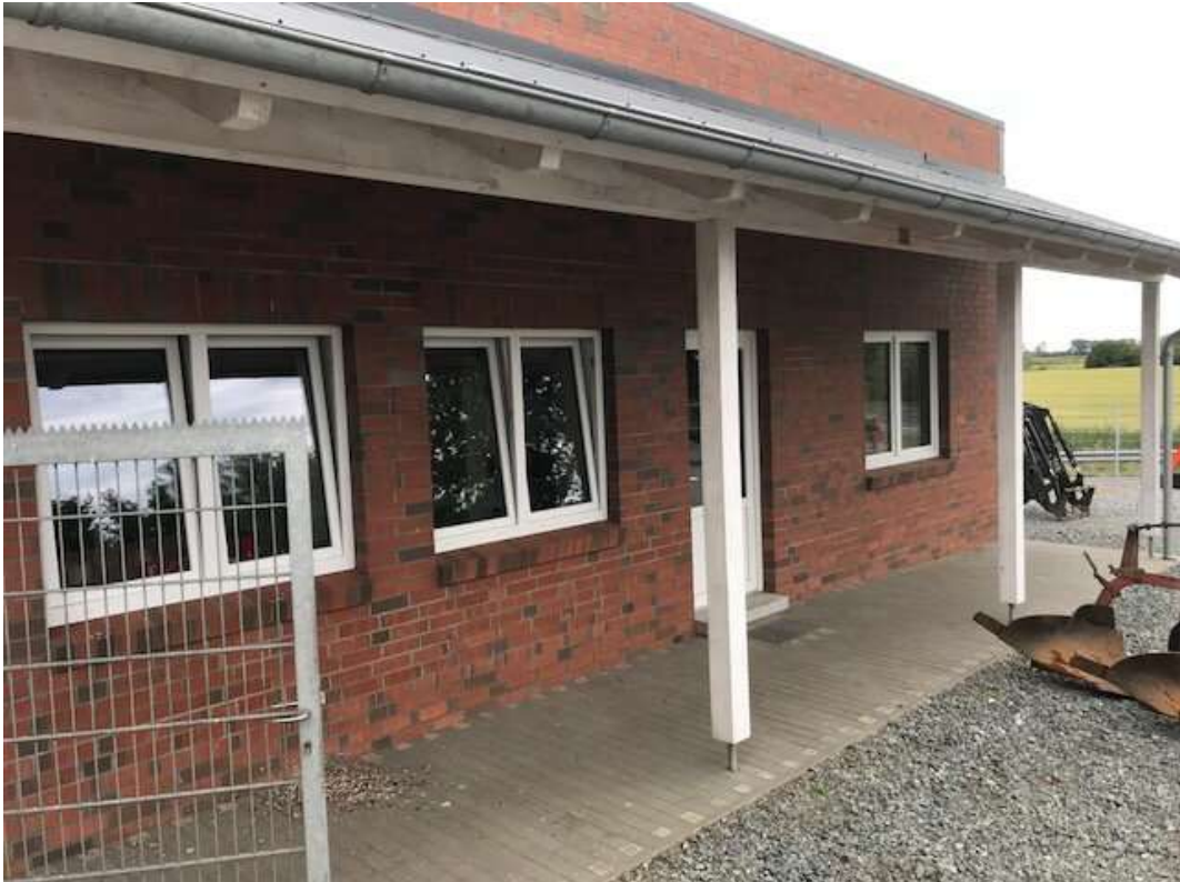
Sanierter Bürotrakt mit überdachtem Eingangsbereich, Klinkerfassade und Verbundpflaster
